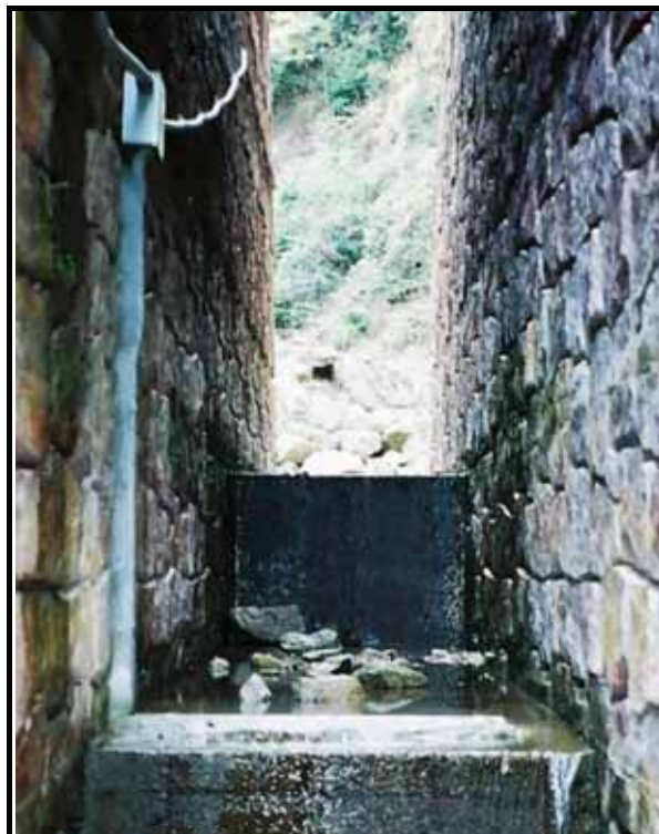
六甲(深谷第4堰堤)に設置した音波管
